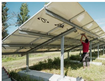
Raccordement électrique des panneaux
