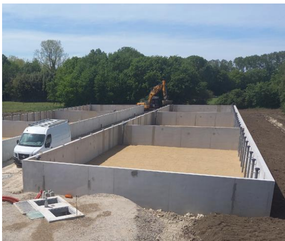
Construction du bassin de lits plantés de roseaux
