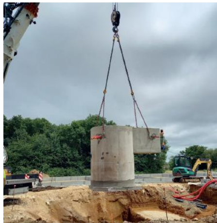
Installation du 1 er poste d'injection dans la station d'épuration
