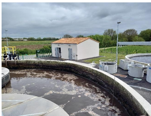
Bassin d'aération (clarificateur au second plan)
