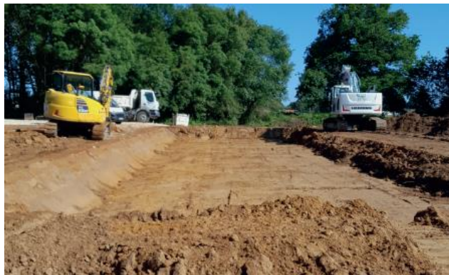
Terrassement du 1 er étage de la station d'épuration pour installer les lits plantés de roseaux
